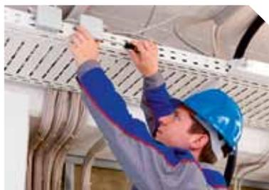
Работа по прокладке кабелей связи по кабельному каналу на улице и в помещении, расшивка кабеля на оконечные устройства, его измерения.
